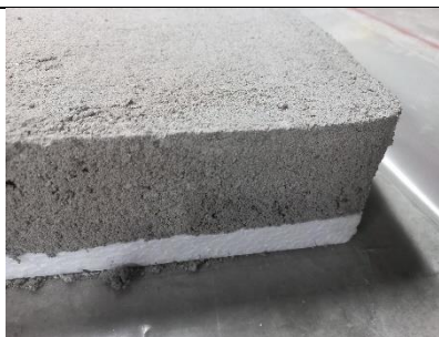
Totale onderzochte zwevende dekvloer
