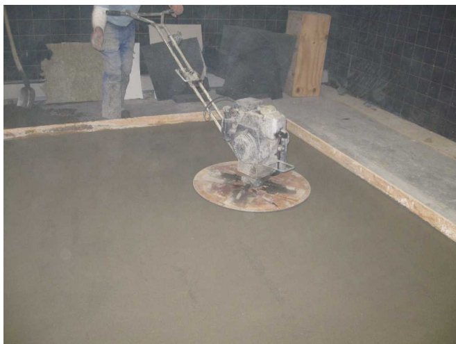
Afbeelding 2: egaliseren van de zandcement dekvloer
