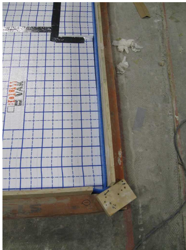
Afbeelding 1: isolatielaag en randstrook in de bekisting
