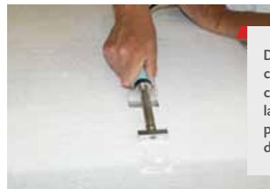
Découpe au thermo cutter pour le passage des câbles électriques, évite la déperdition des billes polystyrène (facilite la gestion des déchets).
