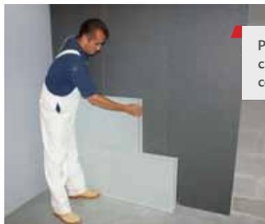
Pose de la contre-cloison : carreaux de plâtre, béton cellulaire, briques, etc
