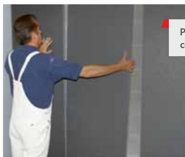
Pose de l'ISOMOTHERM contre cloison
